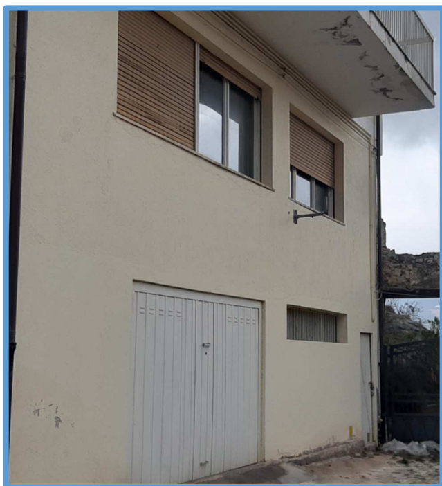
Facciata esterna ingresso Autorimessa
